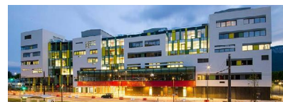
G2Elab, Bâtiment GreEn-ER, Grenoble
